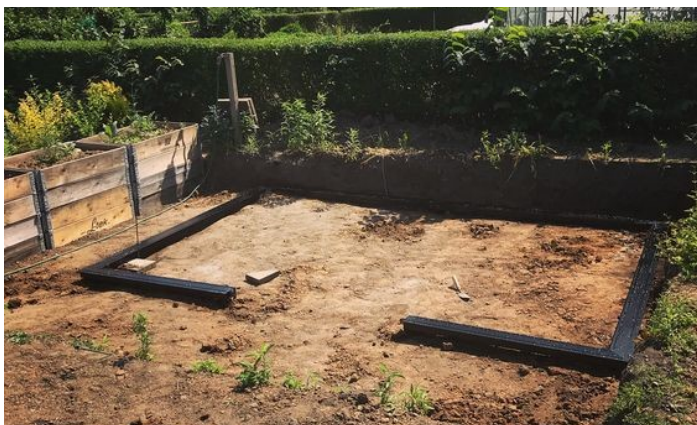
1) Le périmètre de la fondation est positionné, de niveau et scellé au sol avec du béton.
