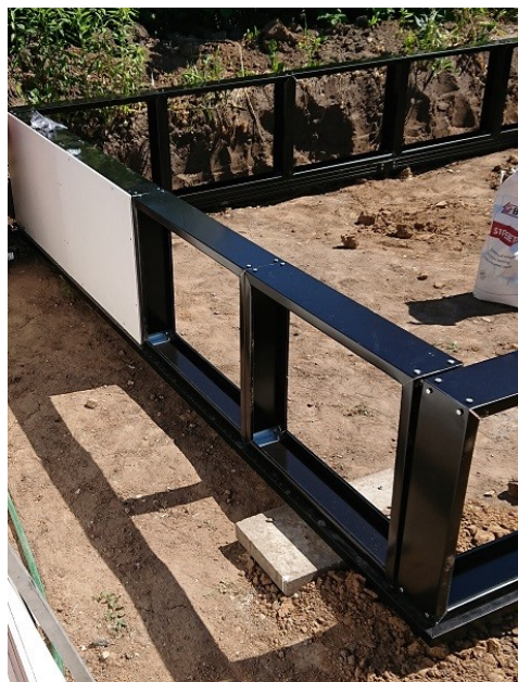
2) Les profiles sont ensuite positionnés sur le périmètre de la fondation et les modules assemblés.
